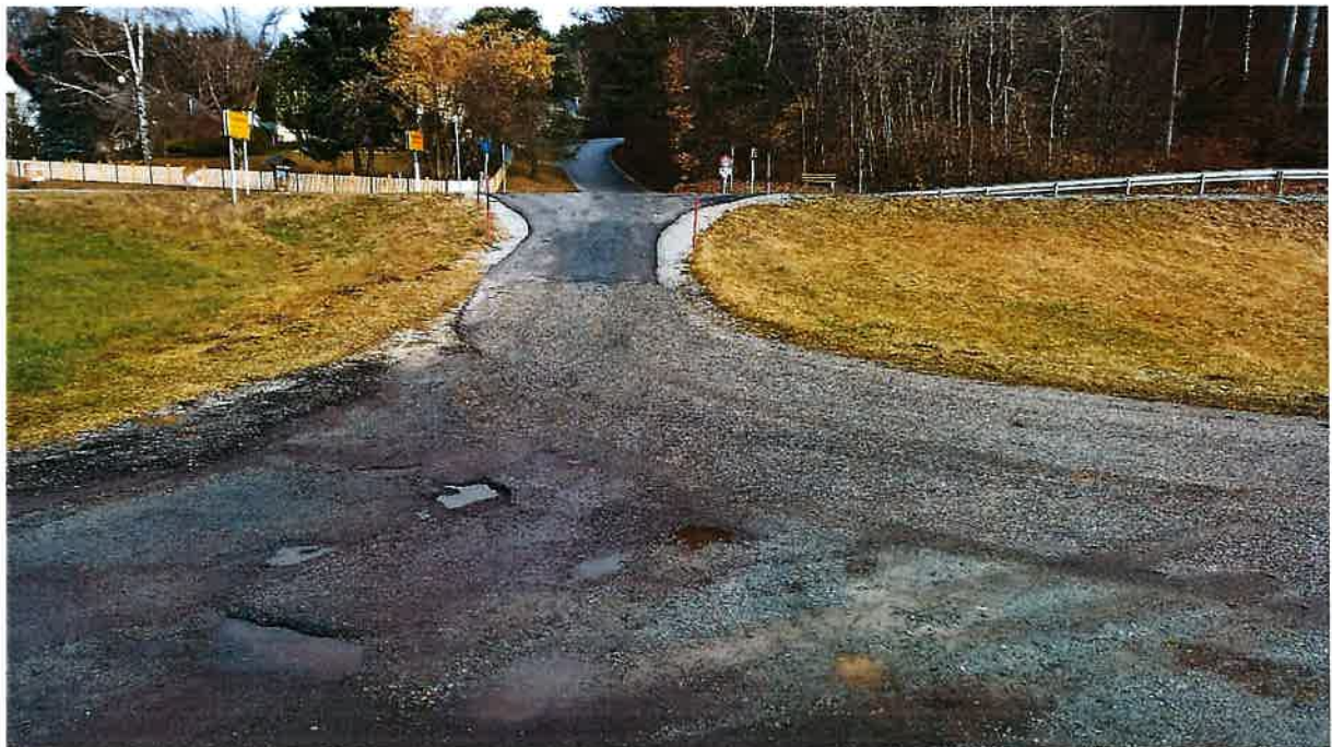
Einmündung bestehende Zufahrt zur B 20
